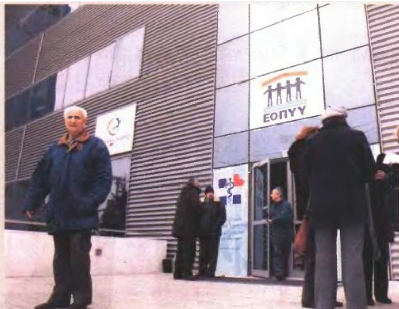
Εκτός από αντισοικονομικό, το κτήριο του ΕΟΠΥΥ στην Κηφισιάς είχε και κατασκευαστικά προβλήματα, αφού παρά το νεαρόν της ηλικίας του συχνά... έβρεχε σοβάδες
