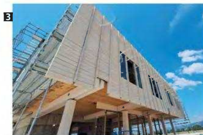
Στα δωμάτια του Παιδιατρικού Νοσοκομείου Θεσσαλονίκης υπάρχει κρεβάτι και για τον φροντιστή, δίπλα στο παιδί (1). Στο εργοτάξιο της Θεσσαλονίκης, η ομάδα του Ρέντσο Πιάνο δημιούργησε ένα ανοικτό εργαστήριο, όπου δοκιμάζονται τα υλικά σε κλίμακα 1:1 (2). Η όψη του Γενικού Νοσοκομείου Κομοτηνής, καλυμμένη με ξύλο από δέντρο ακόγια (3).
